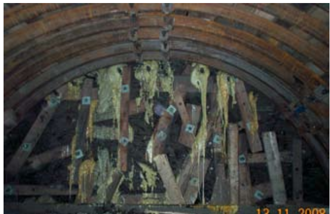
Varovanje močno razrušene čelne stene (sidra Weidman) in »pipe roof« (IBI-sidra + Marithan).
