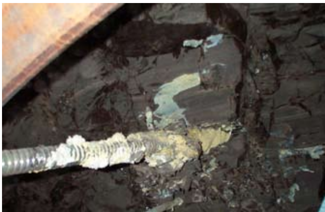
IBI-sidro in injektiran Marithan, ki je po razpokah prodril v hribino.
